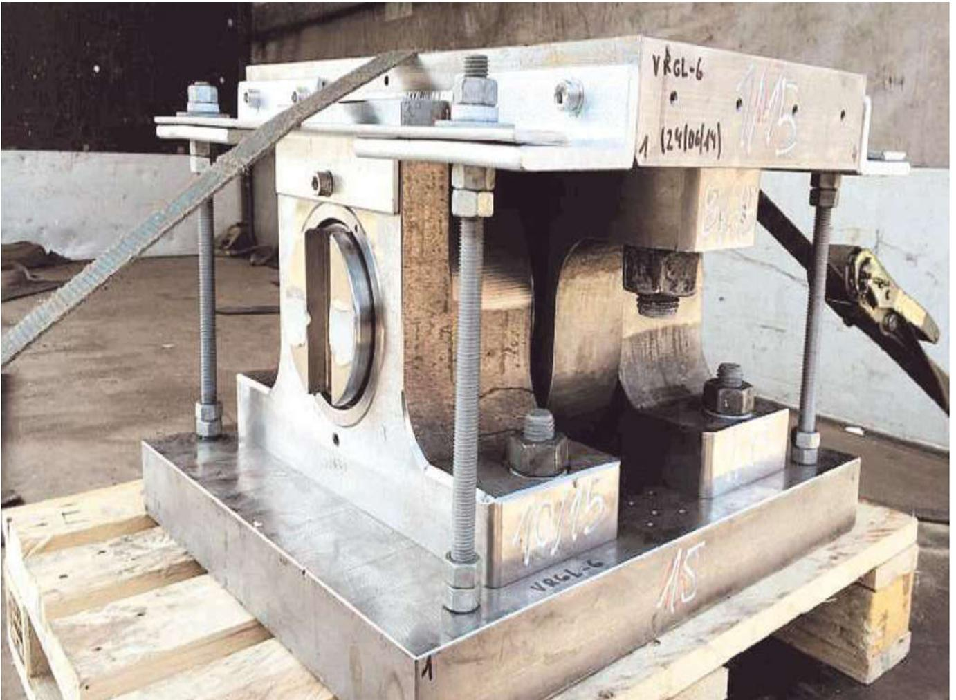
***Auf 126 solcher Radialgelenklager rollt der Verkehr über die Müngstener Brücke.
